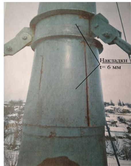
Рисунок 19 – Усиление лацменного узла накладками
