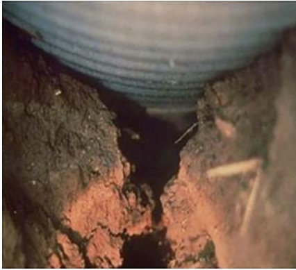
Рисунок 7 – Пример размыва основания
