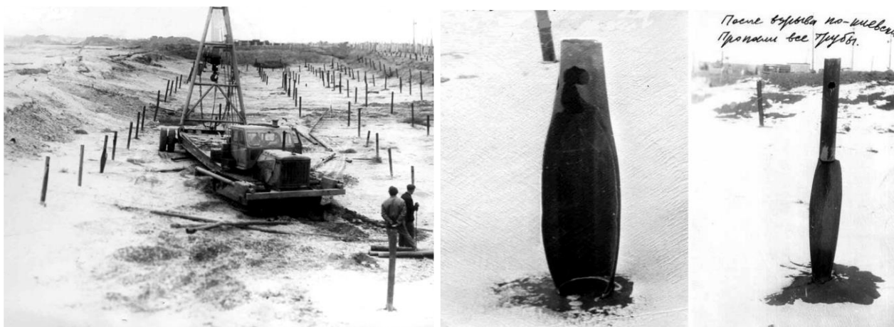
Рис. 8. Просадка (до 2,75 м) после гидровзрывного уплотнения лёссов на стройбазе Буденновска и неудачная попытка выдернуть 3000 пог. метров труб, разорванных взрывами.
