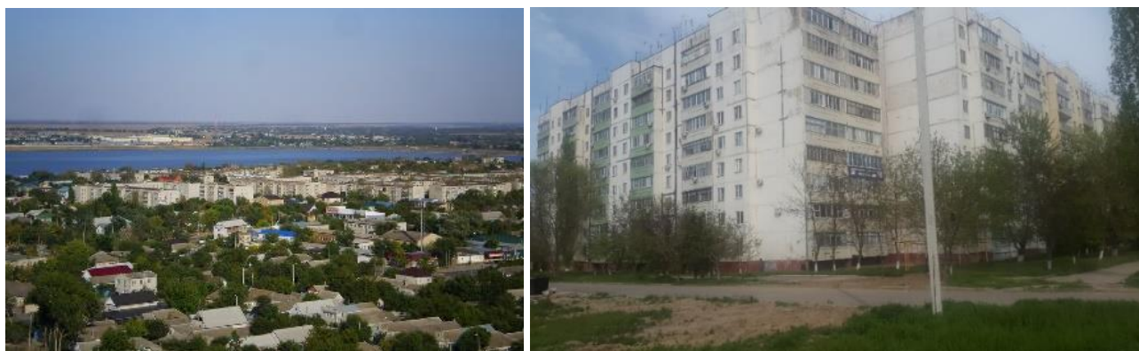
Рис. 9. Общий вид 7-го микрорайона. Вдали Буйвола и Военный городок. Дома, построенные на лёссе, уплотненном глубинными взрывами и буронабивными грунтовыми сваями.
