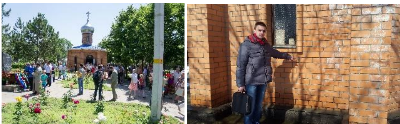
Рис. 13. Часовня, заложенная Б.Н. Ельциным, с трещинами
