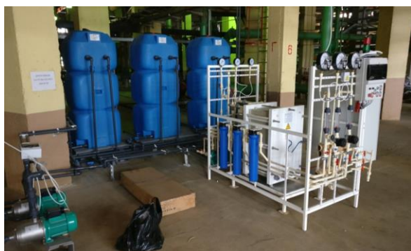
Рис. 3. Общий вид электромембранной установки утилизации высокоминерализованных отходов ионитной ВПУ в химическом цехе (ХВО-2) Нижнекамской ТЭЦ-1
