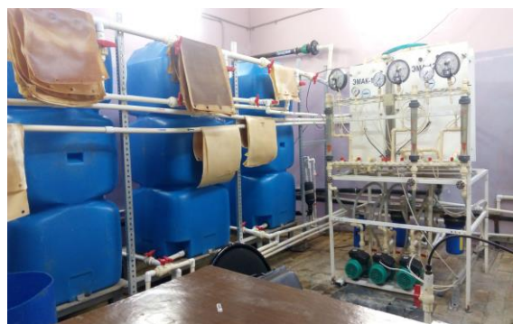
Рис. 3. Общий вид электромембранной установки утилизации высокоминерализованных отходов ионитной ВПУ в химическом цехе (ХВО-2) Нижнекамской ТЭЦ-1
